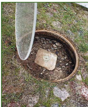
Рис. 7 Центр пункта «Мешконис»
